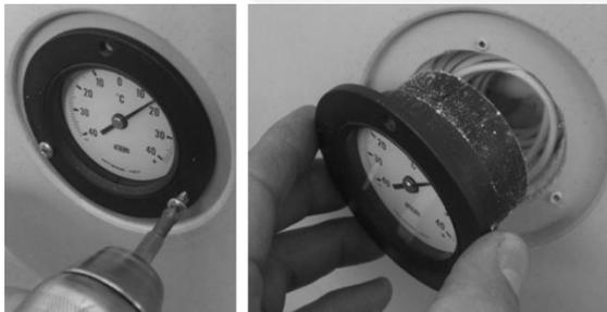
2 - Insérez un nouveau thermomètre en veillant à positionner l'ampoule de la sonde de manière à correspondre aux trous de la plaque de protection de la sonde et à visser les trois vis auto taraudeuses 3.9 X 16mm à tête cylindrique et à découper en croix
