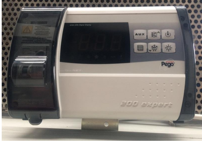
Foto 2 - Quadro di controllo dell'unità frigorifera
