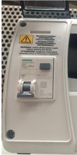
Foto 1 - Magnetotermico differenziale per la protezione e il sezionamento dell'unità frigorifera
