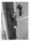
2 – Svitare il dado e la vite antisvitamento M8 con la relativa rondella  $\emptyset10\text{mm}$ .
