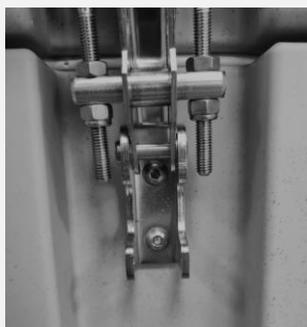
2 – Se necessario, agire in modo analogo con il gancio fissato sul coperchio del contenitore, rimuovendo le due viti di blocco M8x16 con le relative rondelle inox groover
